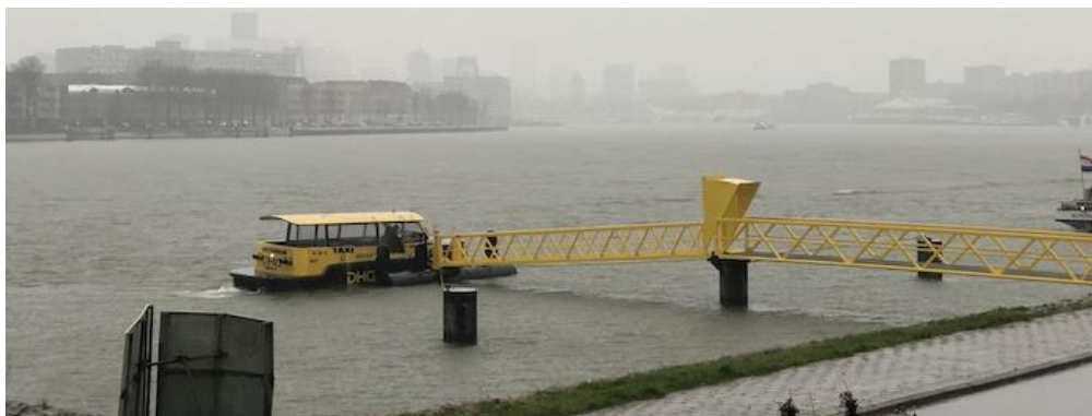
Figuur 2.9 | De loopbrug naar de watertaxi geeft een voorbeeld van hoe een TEO-inlaat constructie eruit zou kunnen zien. De constructie kan meebewegen bij verschillende waterhoogtes.
